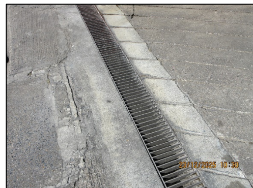
รูปที่ 38 รางระบายน้ำเพื่อรวบรวมน้ำชะมูลฝอย เข้าระบบบำบัดน้ำเสีย
