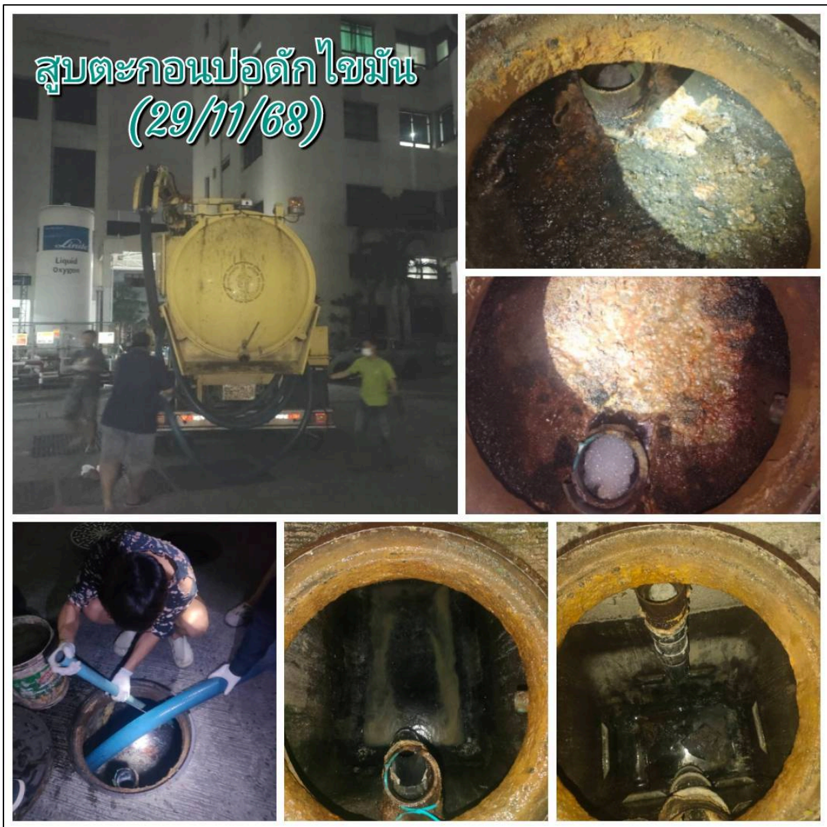
รูปที่ 39 (ต่อ) การสูบน้ำจากบ่อดักไขมัน
