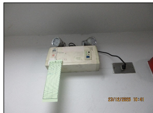
รูปที่ 50 ไฟฉุกเฉิน ระบบไฟสำรองฉุกเฉิน
