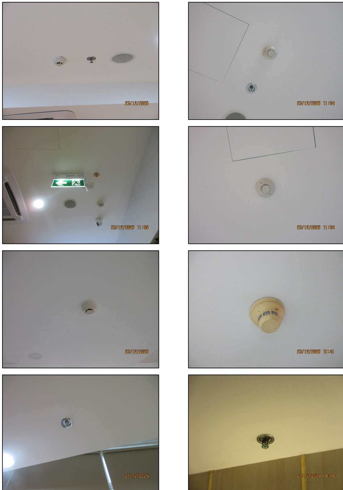
รูปที่ 45 อุปกรณ์ตรวจจับควัน/ความร้อน
