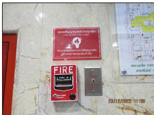
รูปที่ 44 อุปกรณ์แจ้งเหตุเตือนเพลิงไหม้
