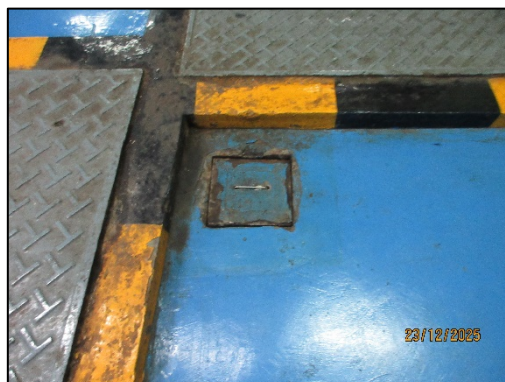
รูปที่ 40 จุด Dilution สารเคมี หรือยาที่หมดอายุ ก่อนระบายเข้าระบบบำบัด
