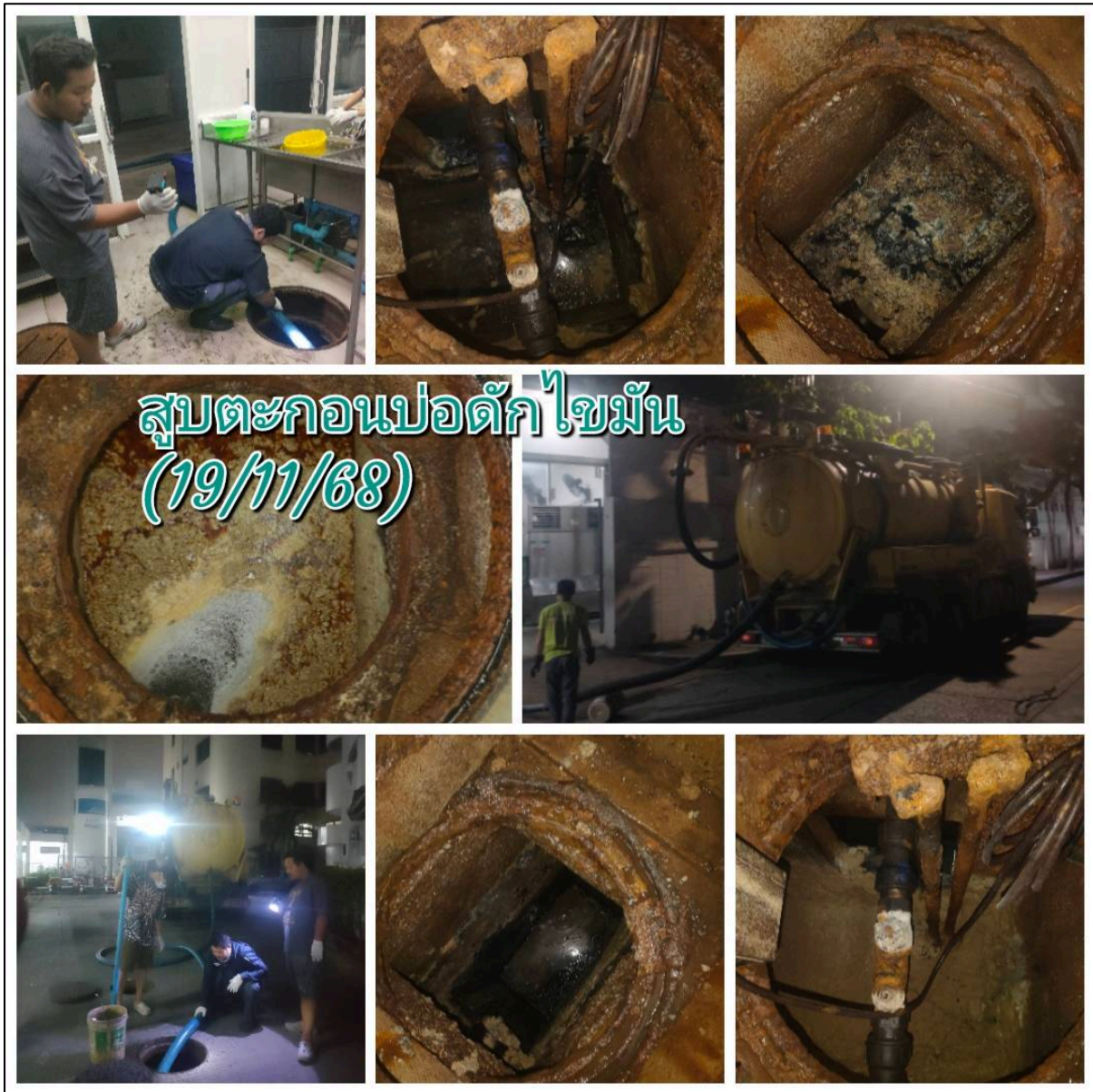
รูปที่ 39 การสูบน้ำมันจากบ่อดักไขมัน
