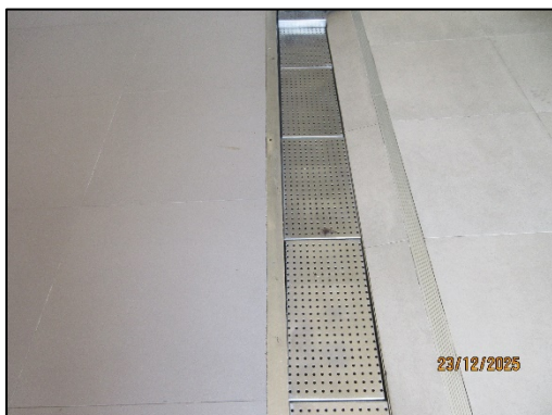
รูปที่ 38 รางระบายน้ำเพื่อรวบรวมน้ำชะมูลฝอย เข้าระบบบำบัดน้ำเสีย
