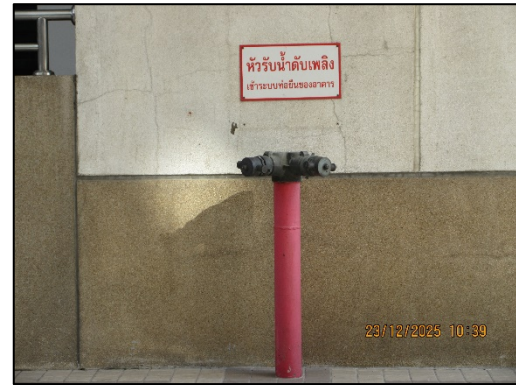
รูปที่ 48 หัวจ่ายรับน้ำดับเพลิง
