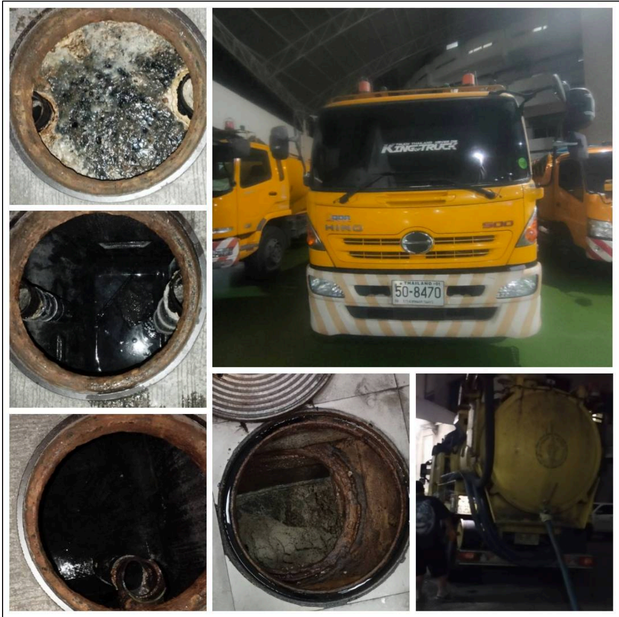
รูปที่ 20 (ต่อ) การสูบล้างท่อระบายน้ำเสีย
