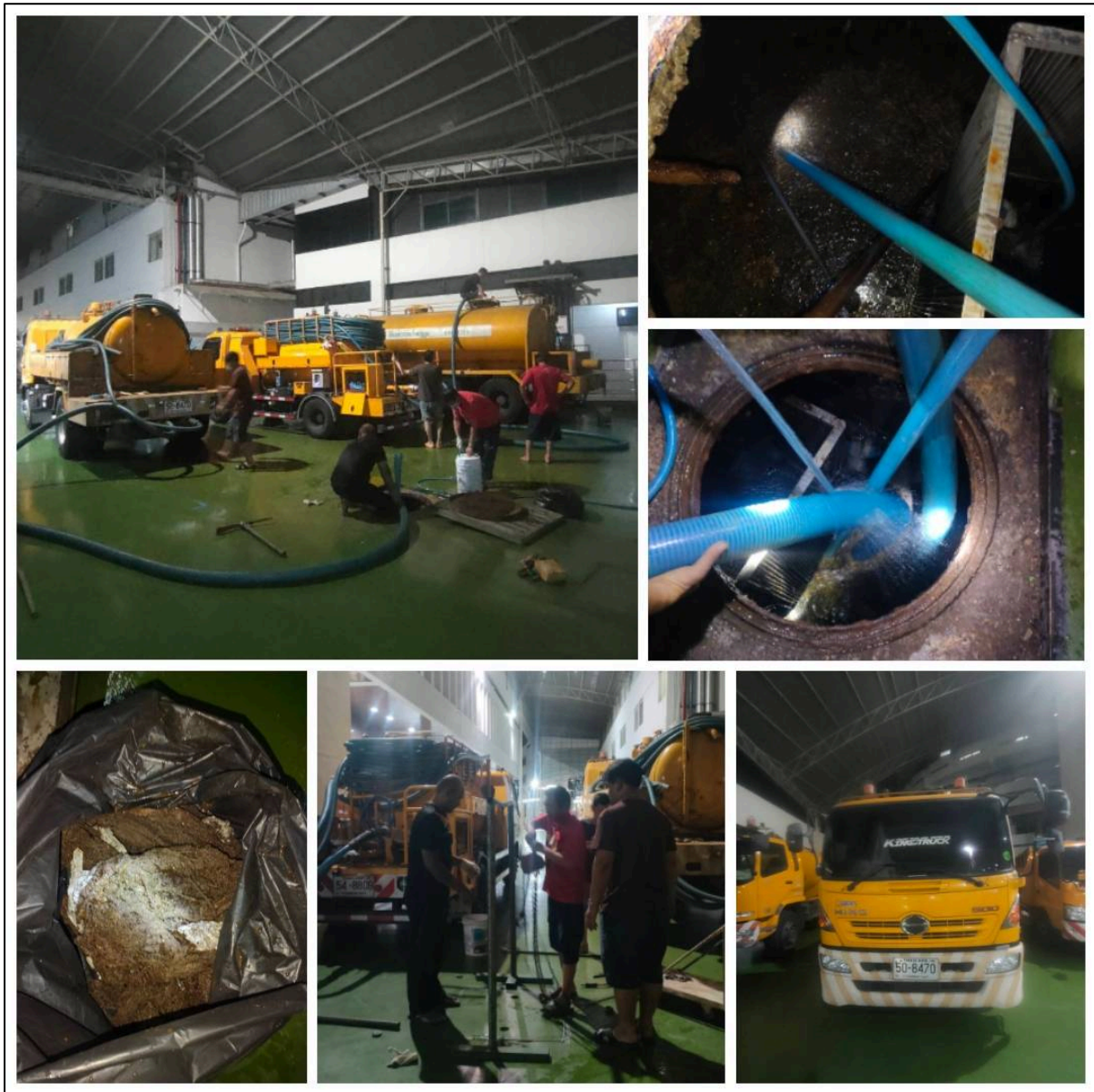
รูปที่ 20 (ต่อ) การสูบล้างท่อบำบัดน้ำเสีย
