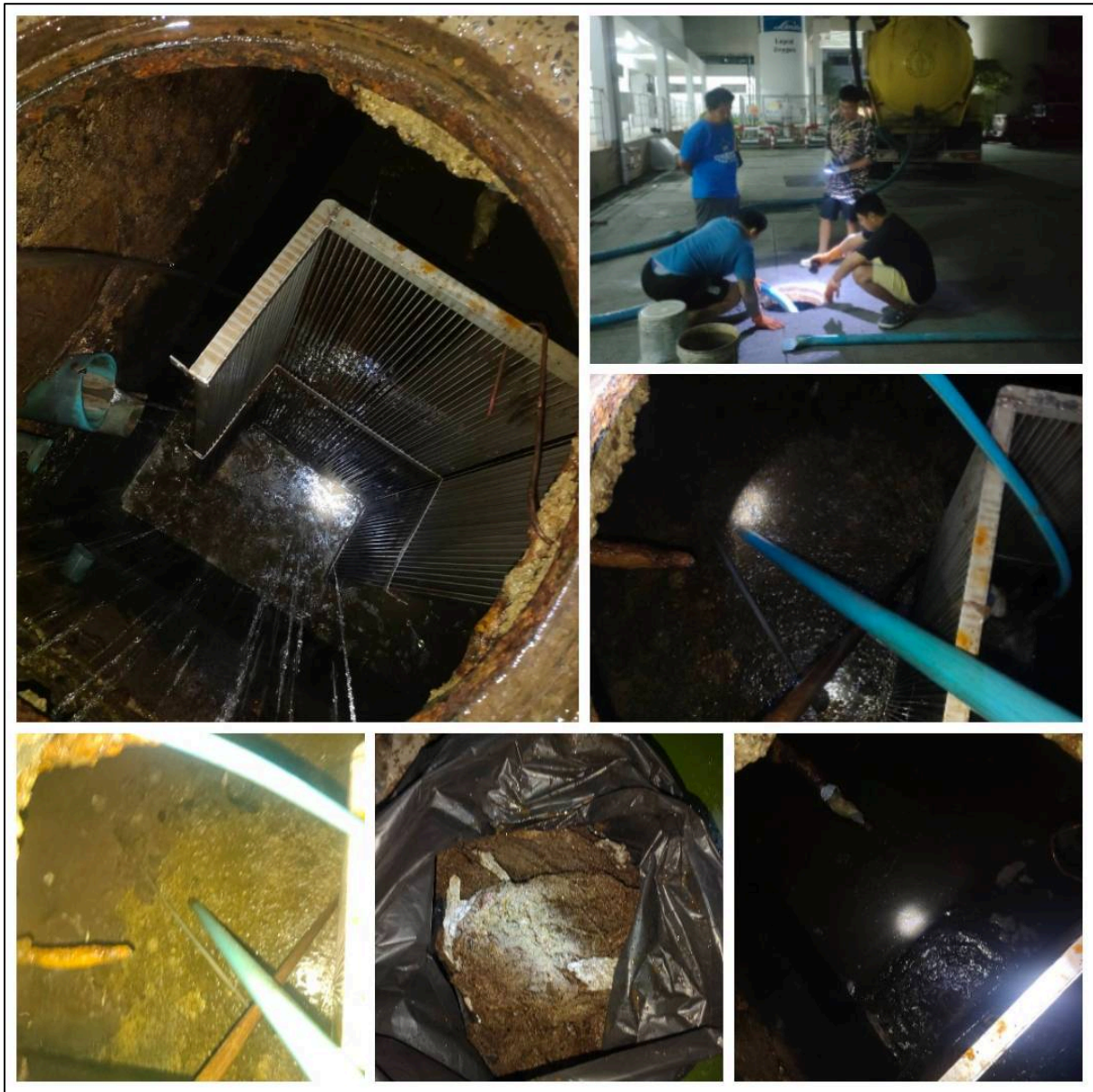
รูปที่ 20 (ต่อ) การสูบน้ำตะกอนบ่อบำบัดน้ำเสีย
